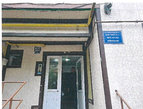
Vedere Acces bloc
