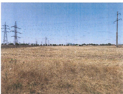
Vedere generala teren
