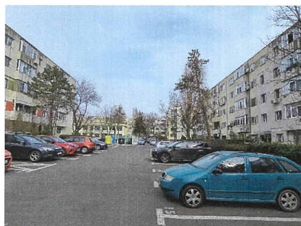
Vedere generala cale acces si vecinatati
