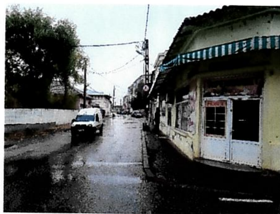
Vedere cale acces si vecinatati
